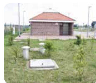
Pumpstation an der Autobahnraststätte
