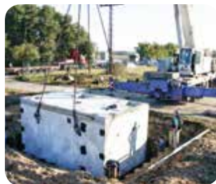
Setzen einer schlüsselfertigen Pumpstation mit anschlussfertiger Installation
